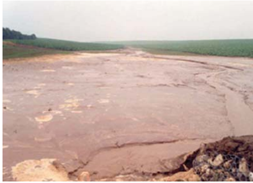
Foto 10 : Buffering van afstromend water in opvangzone net stroomopwaarts van damconstructie (Heulen Gracht, 2002).
